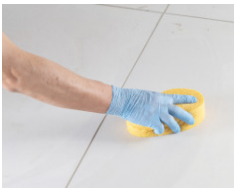
Fugahézagok tisztítása és felületképzése kemény cellulóz szivaccsal
