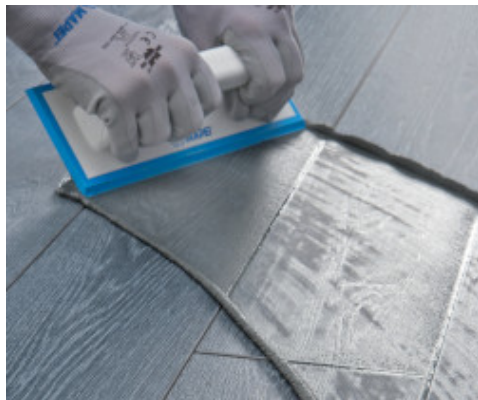
Ultracolor Plus terítése fa hatású gres padlóburkolaton gumisimítóval
