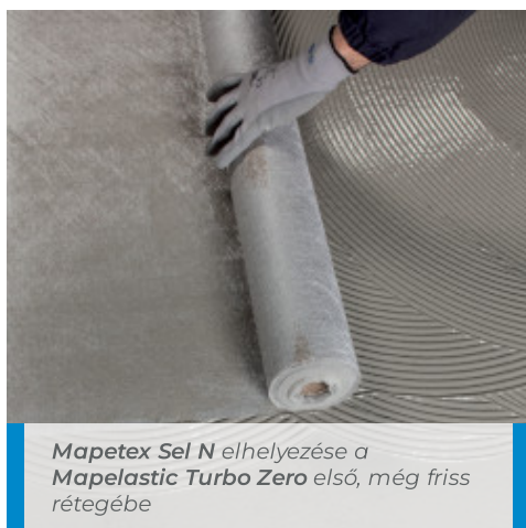
Mapenet 150 elhelyezése az első réteg Mapelastick Turbo Zero -ba, amíg az még friss
