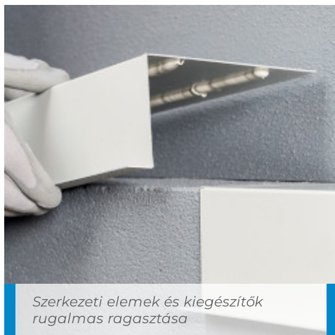
Rugalmas hézagkitöltés szerkezetek csatlakozásainál
