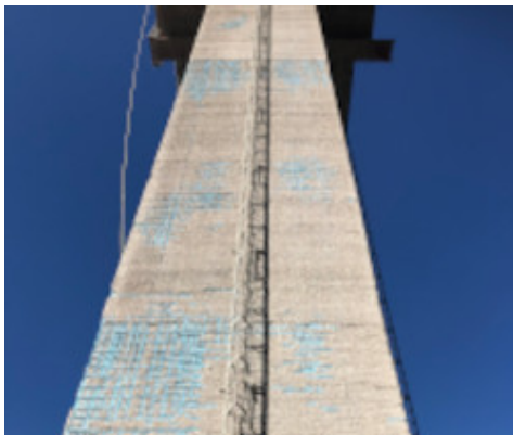
Mapefer 1K Zero felhordása viaduct betonacélokra
